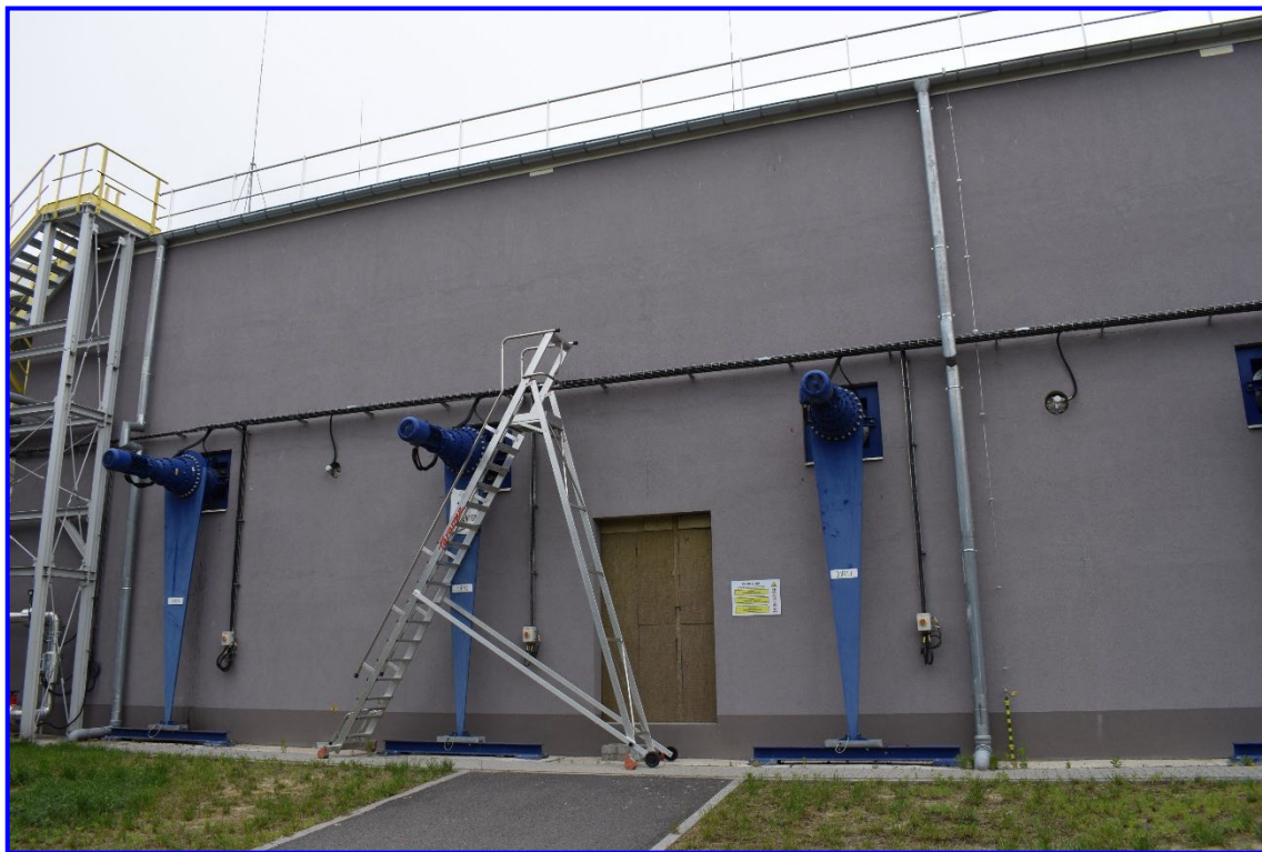
20. Widok bioreaktora (fermentatora) z widocznymi silnikami mieszadeł.
