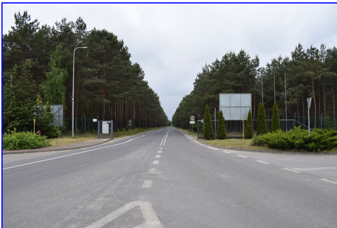
3. Droga dojazdowa do Zakładu Unieszkodliwiania Odpadów Komunalnych w Orlim Stawie od strony bramy głównej.
